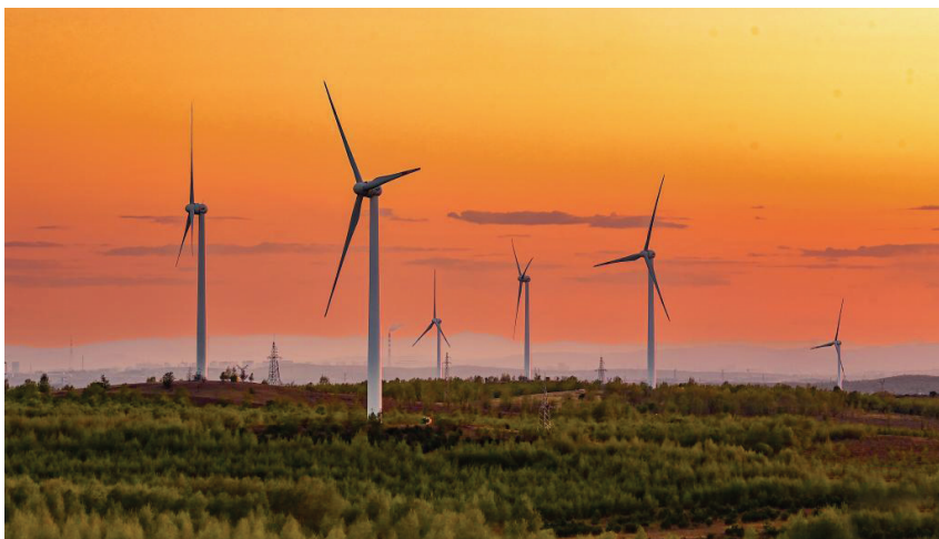
5月23日清晨拍摄的兴安盟乌兰浩特市呼和马场风力光伏发电场内的风机。近年来,内蒙古自治区兴安盟坚持生态优先、绿色发展理念,依托丰富的风能、太阳能资源优势,持续发展风电、光伏等新能源产业。截至目前,全盟新能源装机规模达到659万千瓦,千万千瓦级新能源产业集群雏形初现,推动区域经济高质量发展。
