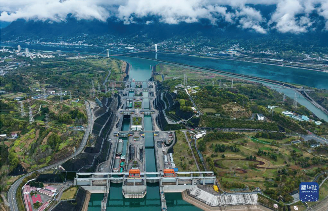
11月22日拍摄的三峡五级船闸，南线船闸已无水即将复航（无人机照片）。当日20时，三峡南线船闸2022年计划性停航检修圆满完成，提前12小时恢复通航。本次检修为期30天，主要完成了人字门、反弧门检修、南线浮堤夏船改造、闸室及廊道金属结构检修等29项检修内容。
