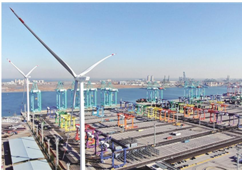
↑12月15日,随着天津港北疆港区C段智能化集装箱码头北侧的两台风机叶片缓缓启动,全球首个零碳码头智慧绿色能源系统投用,并在天津港并网发电。此次并网发电的智慧绿色能源系统包含风电和光伏两部分,预计每年总发电量将达2330.2万千瓦时,将节约标煤约7340吨。图为天津港北疆港区C段智能化集装箱码头。李四航 摄(中经视觉)
