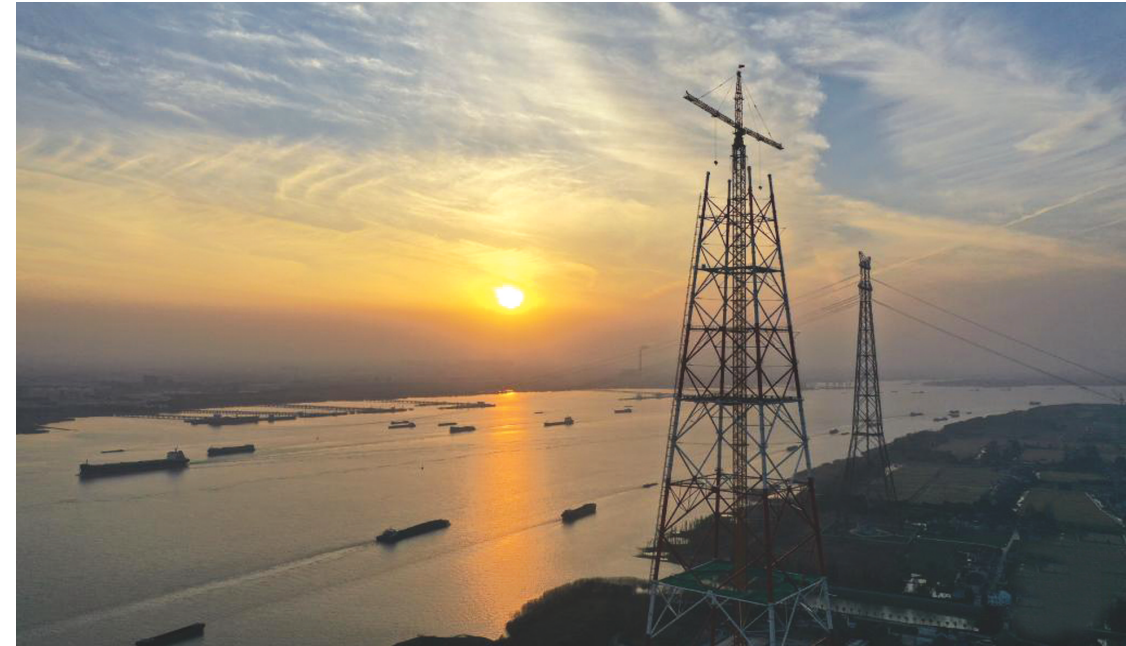
↑江苏凤城—梅里500千伏线路长江大跨越工程是江苏省境内新增的第五条500千伏过江通道。目前，工程建设稳步推进，建成后将有效提升长三角能源电力一体化水平，大幅提升地区新能源等绿色能源利用效率，降低长三角地区总体碳排放水平，全力支撑长江两岸经济社会发展。这是建设中的江苏凤城—梅里500千伏线路长江大跨越工程(11月3日摄，无人机照片)。 新华社记者 季春鹏 摄
