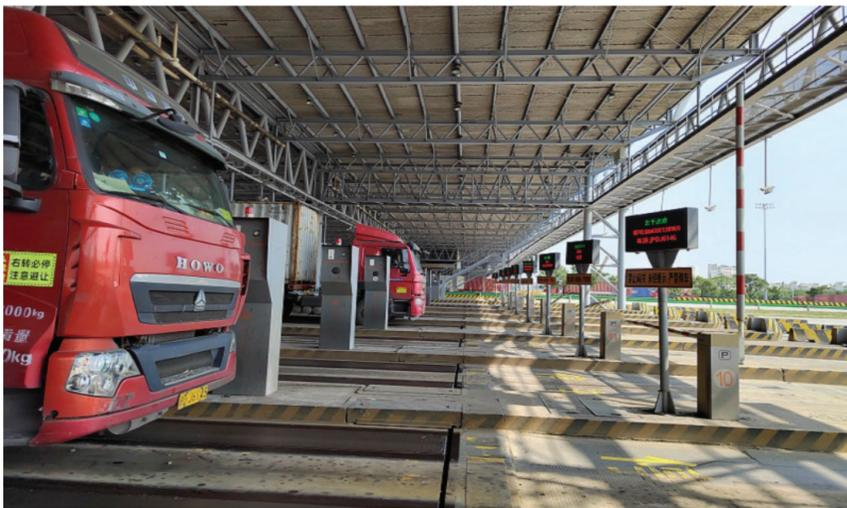
缓缓进入指定海关通道,准确停靠卡口停车限位区。智能道口交互系统迅速识别车牌及集装箱号,旁侧显示屏随即显示“准予进港”,道杆自动抬起,车辆启动快速过卡……
