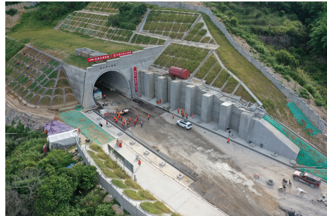
↑这是7月12日拍摄的新建福厦铁路新大顶山隧道（无人机照片）。当日，由中国中铁大桥局承建的新建福厦铁路新大顶山隧道举行顺利贯通仪式，至此，新建福厦铁路正线隧道全部贯通。新建福厦铁路是我国首条跨海高铁，设计时速350公里。
