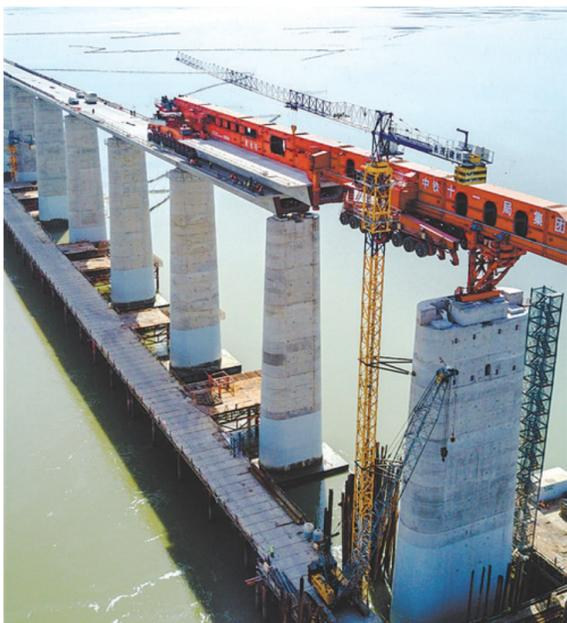
7月11日,在新建福厦铁路湄洲湾跨海大桥建设现场,“昆仑号”在架设该线路最后一孔40米箱梁。“昆仑号”是目前世界唯一的千吨级运架一体机,自2020年首次在新建福厦铁路湄洲湾跨海大桥建设现场亮相以来,共架设40米高铁箱梁298孔。新华社记者 宋为伟 摄
