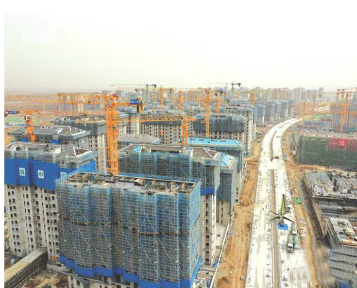
3月17日拍摄的河北雄安新区容东片区安置房项目建设现场(无人机照片)。 记者从河北雄安新区管委会了解到,截至3月16日,容东片区安置房项目已有833栋完成结构封顶,室内外装修、楼内精装修施工同步开展。 新华社记者 牟宇 摄
