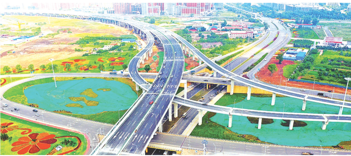
↑近日,作为吉林首个应用预制装配式技术建设的高架桥项目——长春东部快速路南延工程桥梁主线通车。该项目连接长春市中心城区与净月高新区,未来将与在建的长春至双阳快速路连接,对于完善长春市“两横三纵”快速路系统,缓解东南部区域交通压力提供有力支撑。
